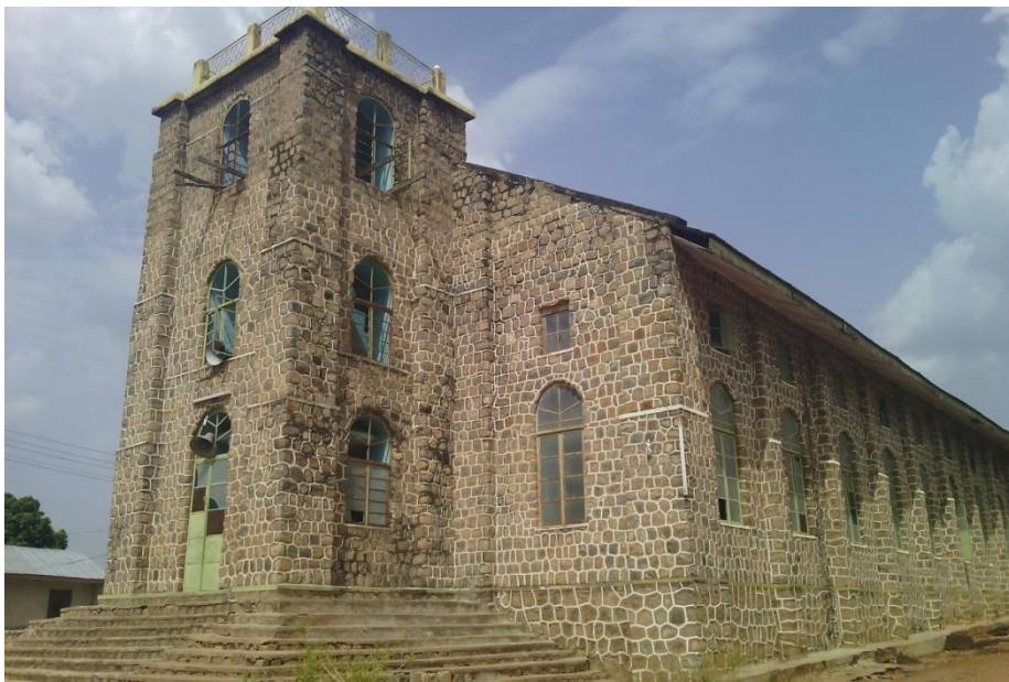
1 ST ECWA Òrò-Àgó (built with stones)
